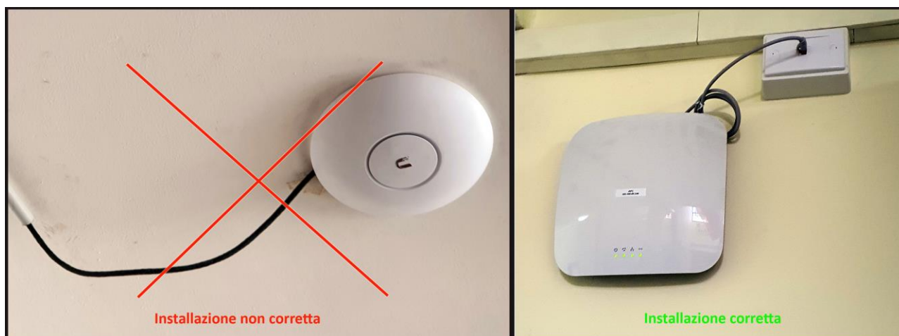
Figura 10 – Installazione corretta dell'Access Point
